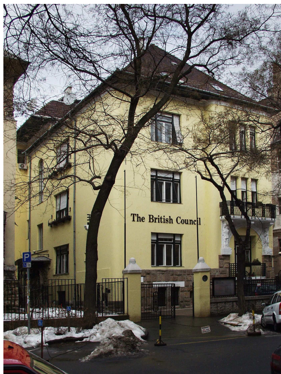
Benczúr utcai homlokzat
